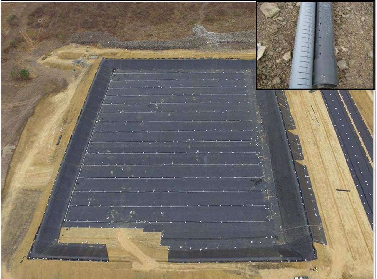
**Ejemplo: Imagen de un Módulo impermeabilizado y caños de Ø110 mm, con ranuras para permitir la entrada de lixiviado**
