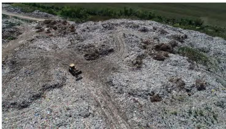
compactación de los residuos en la celda principal, así como la consolidación de tres caminos para posibilitar el acceso vehicular. Material árido fue dispuesto en dichas superficies, lo cual facilita en gran medida las tareas de disposición y posterior compactación de los residuos en el nivel superior de la celda. Se acondicionó el camino de acceso en toda la extensión del predio, para evitar el desgaste de los vehículos que circulan.
