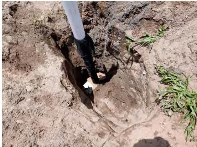
Figura 3.3 Entubamiento PVC con cañería de enclavamiento y previa conformación de calicata
